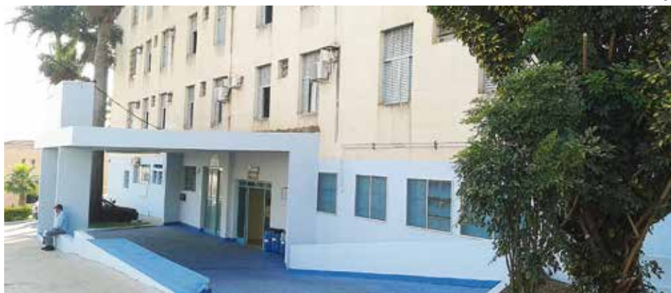
Pronto-Atendimento Municipal funciona desde julho no prédio do Hospital São Judas: baixa complexidade
